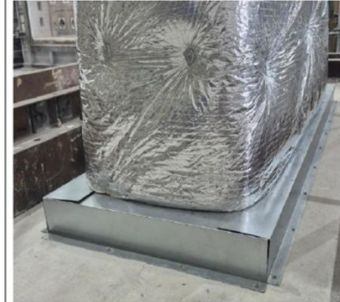
[덕트 인정구조 시공 마감사진]
