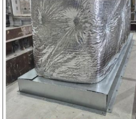
[덕트 인정구조 시공 마감사진]
